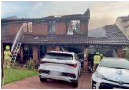
Penshurst'teki bir evin içindeki bir pil yangınının ardından. (Kaynak: Fire and Rescue NSW)
