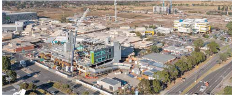
Epping'deki Hastanede, 30 yataklı bir ruh sağlığı tesisinin inşaatı devam ediyor. 2022 sonlarında tamamlandığında, ciddi zihinsel sağlık sorunları yaşayan yaklaşık 665 kişiye her yıl tedavi sağlanacak.
